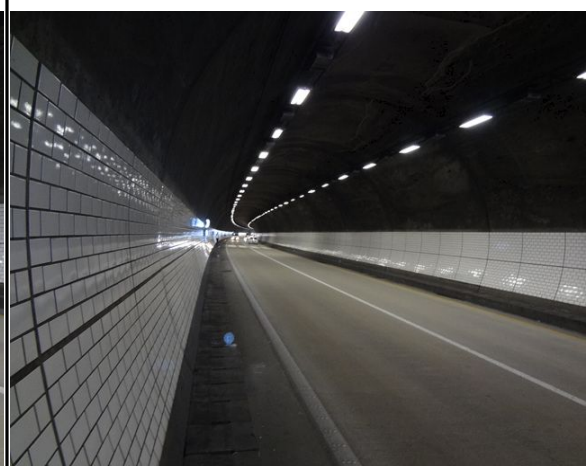
하행선 조명시설 전경
